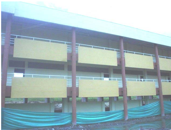
Aspecto de la obra de la ciudadela Universitaria gerenciala por Fonade.
